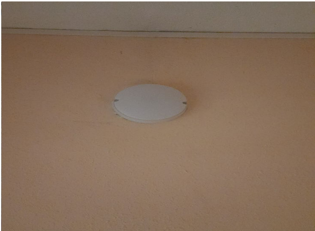
Замена светильников и лампочек
