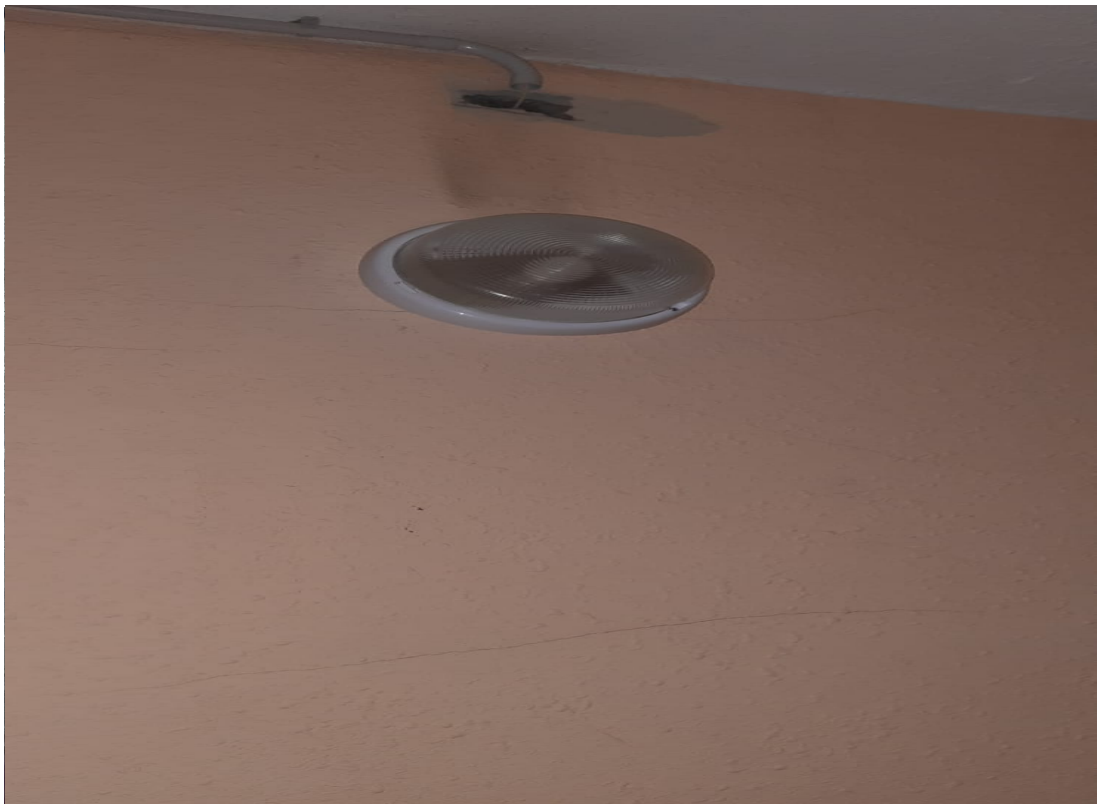
Замена светильников и лампочек
