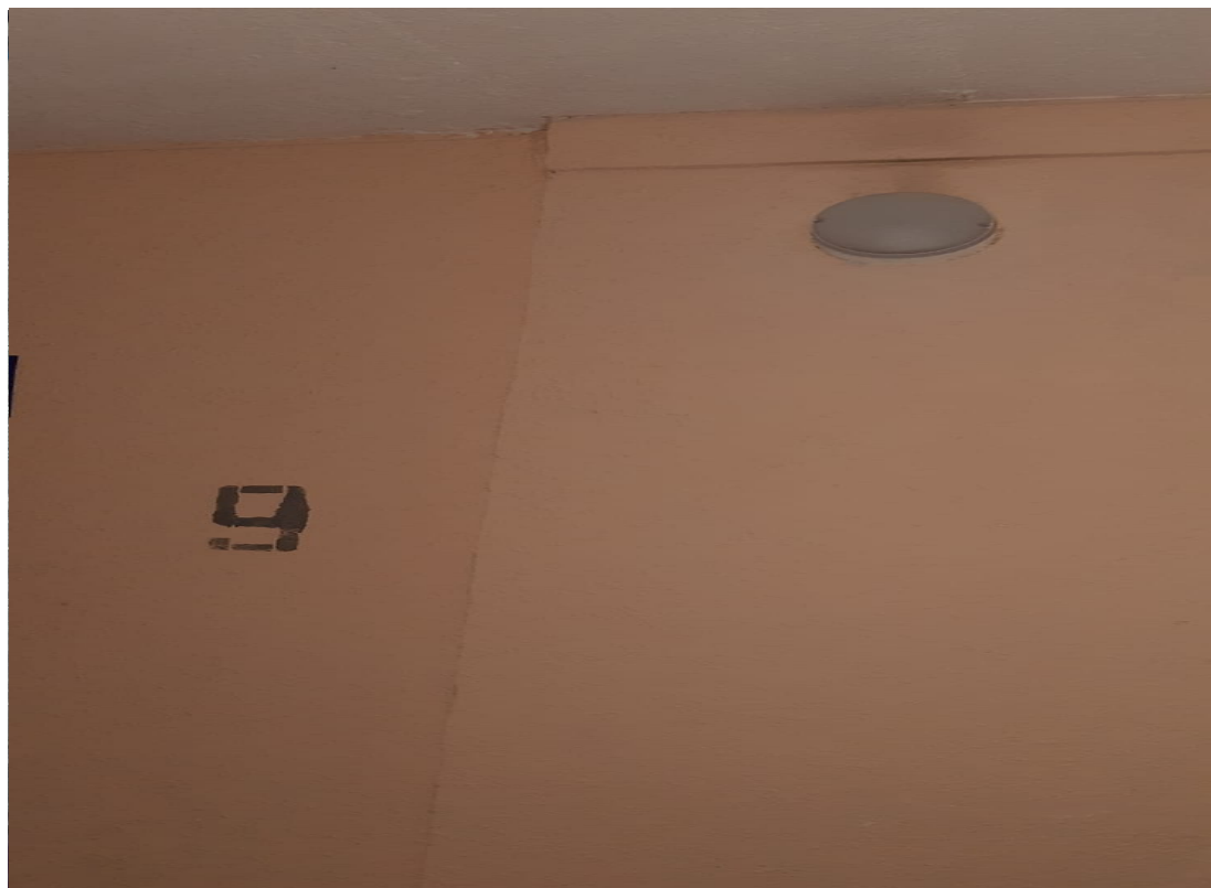
Замена светильников и лампочек
